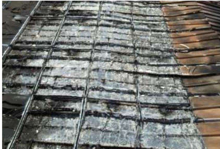
**Il tetto copriva una stalla di una nota azienda agricola, in salvo gli animali. La Stampa locale [4] riporta come possibile causa un guasto elettrico all'impianto fotovoltaico e la successiva propagazione dell'incendio sulla copertura e dalla copertura ai locali sottostanti. Le fiamme sono state alimentate anche da un forte vento direzione sud-nord.**
